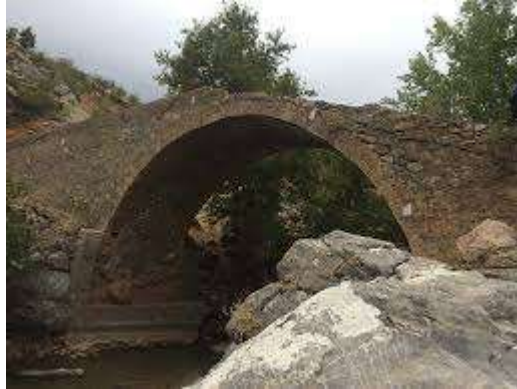
Şekil 1. Korucu (Sucular) Köprüsü
