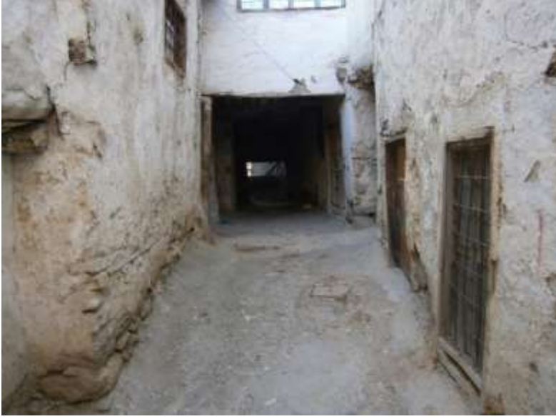
Resim: 7- Pirpiran Sokağı'ndan bir kesit (örtme/tünel/eklentı).
