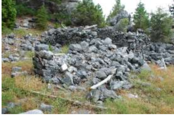
Yol üzerinde harap bir yapı.
